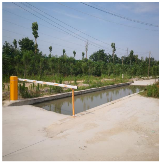
洗车槽沉淀池
