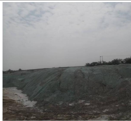
尾灰堆场防尘网覆盖
