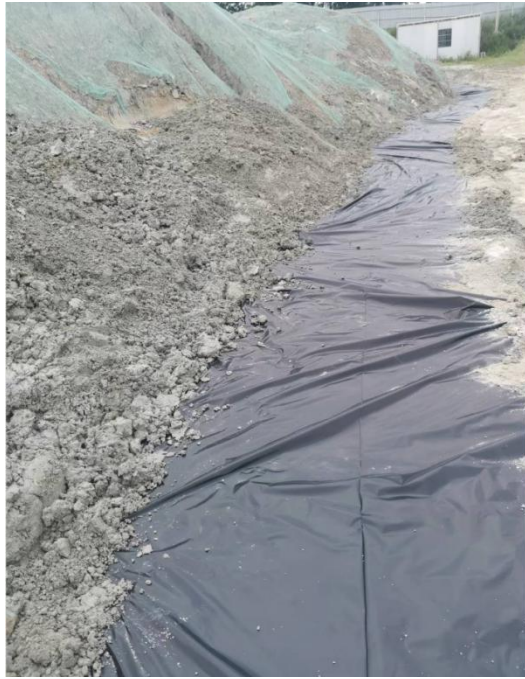
尾灰堆场防渗漏膜
