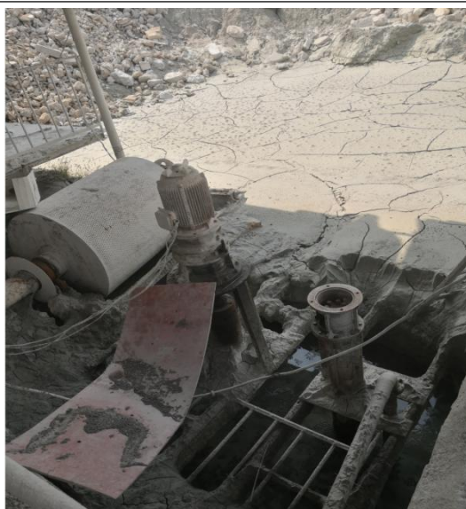
生产废水循环沉淀池
